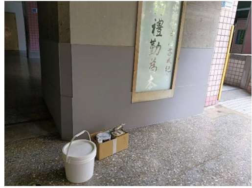
柱面破裂修復
