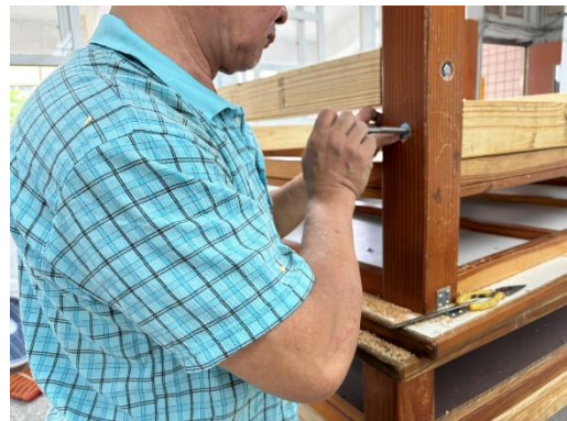
自然專科教室整修— 實驗桌施工加固
